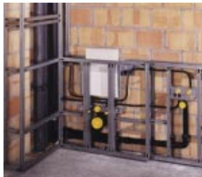
*Convém observar ainda, que o traçado das tubulações deve ser tão retilíneo quanto possível, para evitar a formação de bolhas, o que causaria desconforto ao usuário quando da utilização de algum aparelho sanitário, além de reduzir a quantidade de materiais e também a perda de carga no sistema de distribuição de água, otimizando o diâmetro das tubulações e o consumo na eventual existência de um aquecedor de passagem.*
